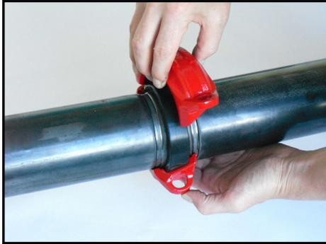
Deslice el acoplamiento abierto sobre la tubería y la junta.
