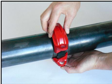
Asegúrese de que los dos segmentos de la carcasa encajan correctamente en las ranuras de las dos tuberías.
