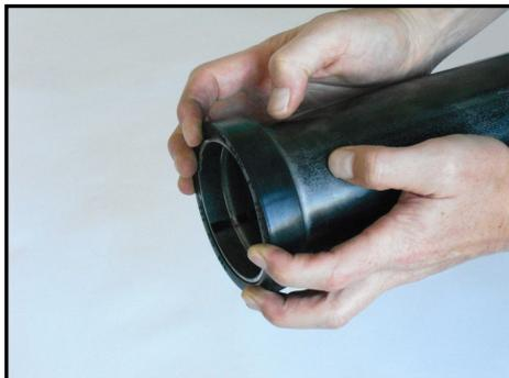
Empuje o tire cuidadosamente de la junta sobre el extremo de la tubería hasta que vuelva a verse la hendidura.
